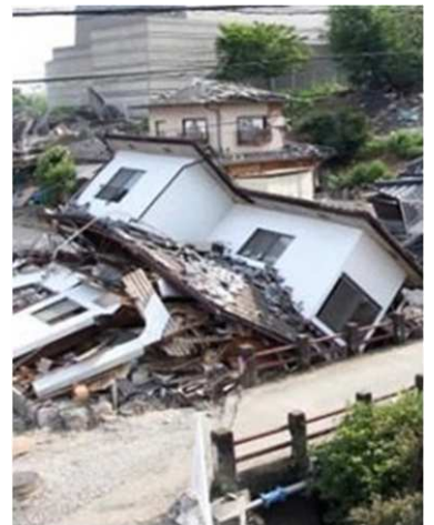
地震で倒壊した家屋
